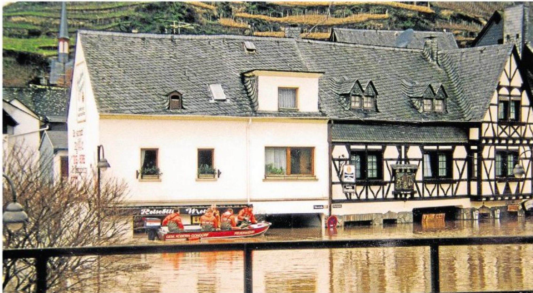
Nur mit Booten zu befahren war die Fährstraße beim Hochwasser 1993. Könnte ein Schutzdamm ein solches Szenario verhindern?
